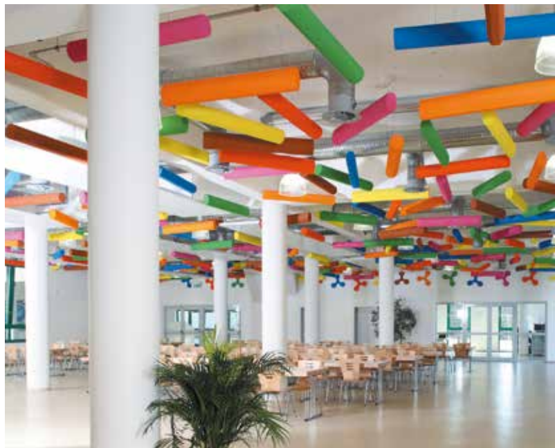
Geluidshinder duurzaam teruggebracht: een aangenaam klankbeeld is ontstaan door de toepassing van Melapor-elementen in de mensa van scholengemeenschap Wesseling.
