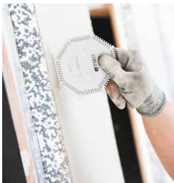
Meting in het technisch centrum van DAW van de dikte van de laag bij een wapening
