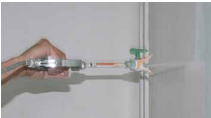
Nespri-TEC is een slim en veilig systeem voor het aanbrengen van muurverven op een manier die het milieu ontziet, zonder spuitnevels.
