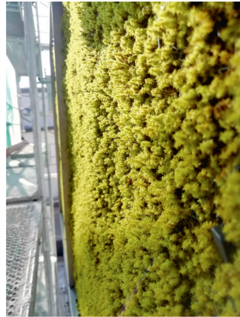
Fassadenelemente mit Mooskulturen filtern Schadstoffe aus der Umgebungsluft Moss-based façade components filter pollutants from the ambient air
